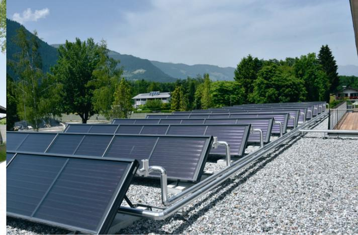
Zirka 153 m<sup>2</sup> Kollektorfläche am Dach für die thermische Solaranlage.
